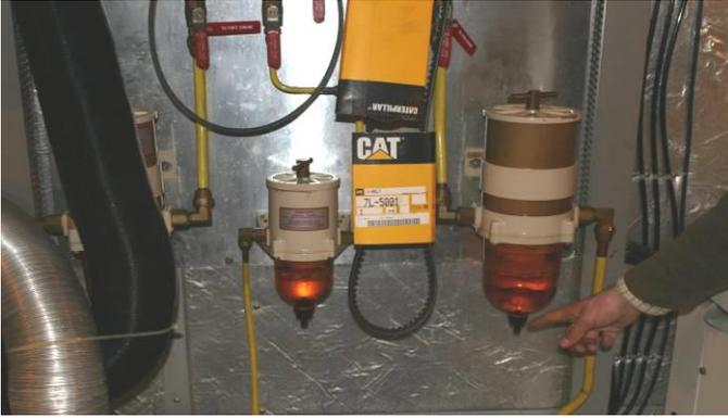
Jeder Motor verfügt über einen **Vorfilter**, der gleichzeitig Wasserabscheider ist. Sollte **Wasser im Diesel** sein – was in Kroatien leider immer wieder passieren kann – so kann dieses, da es schwerer als Diesel ist – durch Öffnung der Ablassschraube am Vorfilter abgelassen werden.
